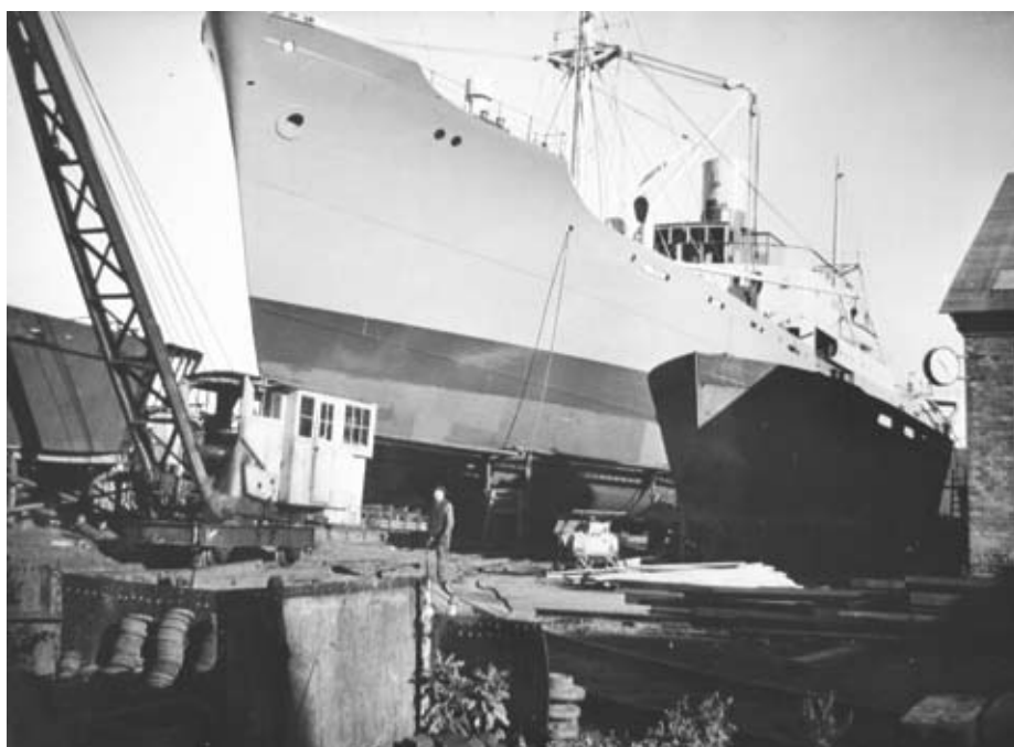
Fartyget Produce som byggdes på Gävle varv ligger på slipen hösten 1945 för bottnmålningen och för montering av propeller och roder.
